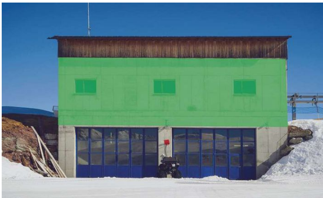
Auf der grün eingefärbten Südfassade der Schwarzseealp-Bergstation sollen demnächst Solarpanels montiert werden.
