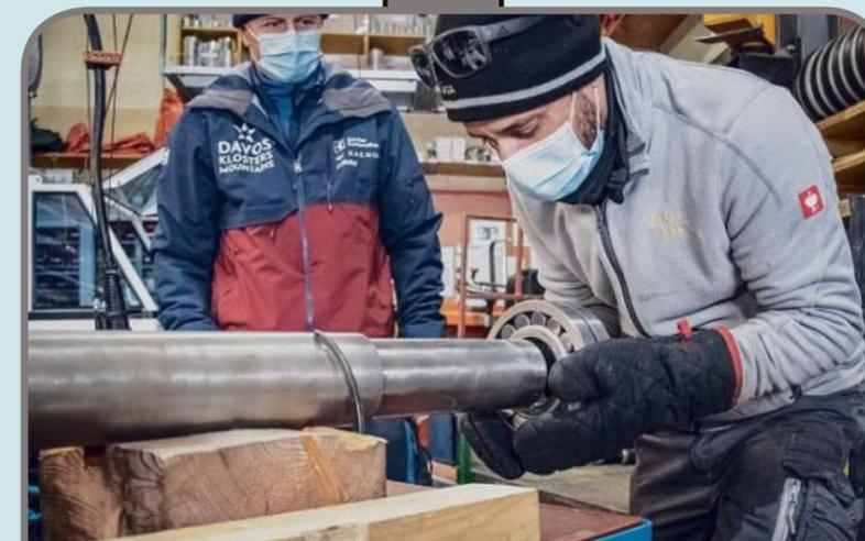
Das neue Pendelrollenlager wurde erhitzt und anschliessend auf die Getriebewelle geschoben.
